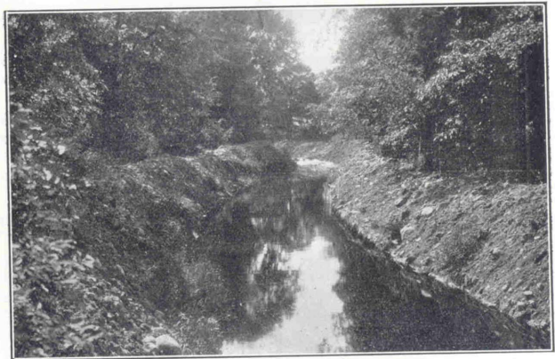
Le même cours d'eau après le passage de l'excavateur-mécanique.
