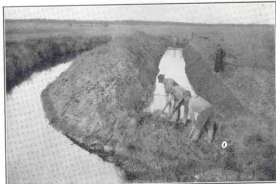
Redressement fait à la pelle à main. Le coût initial sera facilement remboursé par l'économie réalisée dans l'entretien du cours d'eau.
