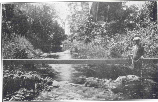
Cours d'eau municipal insuffisant pour l'écoulement des eaux.
