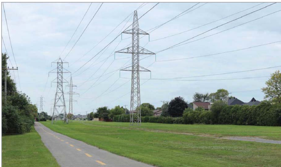
Figure 10 La vue simulée de la ligne à 315 kV sur pylônes en treillis
