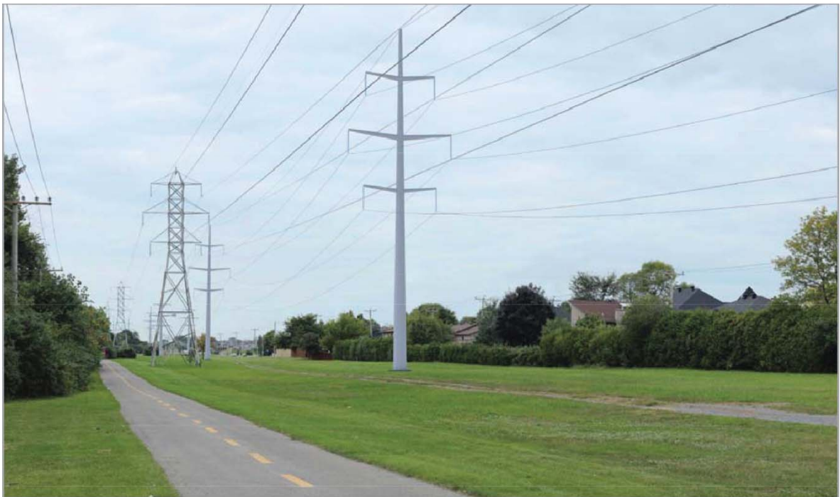
Figure 9 La vue simulée de la ligne à 315 kV sur pylônes tubulaires
