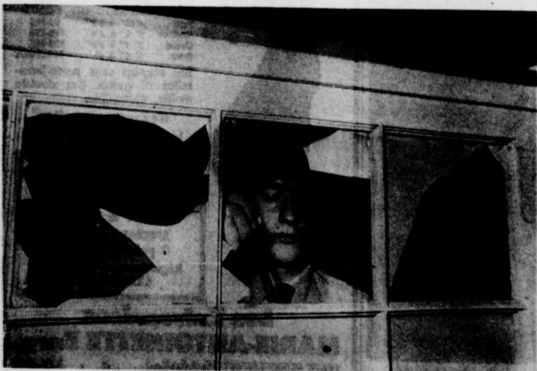
L'examen d'une fenêtre qui a été brisée au cours d'un vol par effraction. Comme on peut le constater, on veut que ces cours de perfectionnement soient complets.
