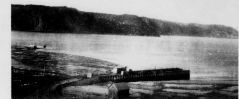
Le Port en 1916. Premier quai de bois construit par J.E.A. Dubuc.
