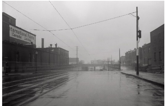
L'usine de l'International Paints (à gauche), en 1943.
