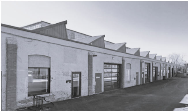
Ancien bâtiment de Caron Frères / Ateliers Belleville. Source : Google Maps, 2014
