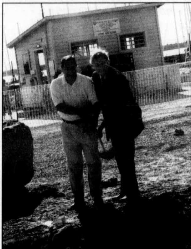
Le conseiller municipal André Levac et le Commodore, Jean-Claude Demers font la première pelletée de roches sur le site de la future capitainerie d'Aylmer. En arrière-plan, le «cabanon» qui servait de capitainerie jusqu'à maintenant. Photo: Yannick Boursier
