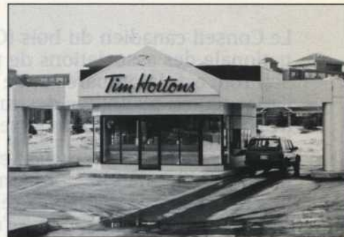
La construction modulaire de NRB a permis de compléter la construction sur le site en moins de 10 jours. Les comptoirs de service et présentoirs à beignes ont été fabriqués à l'usine et livrés en position, en un module.
