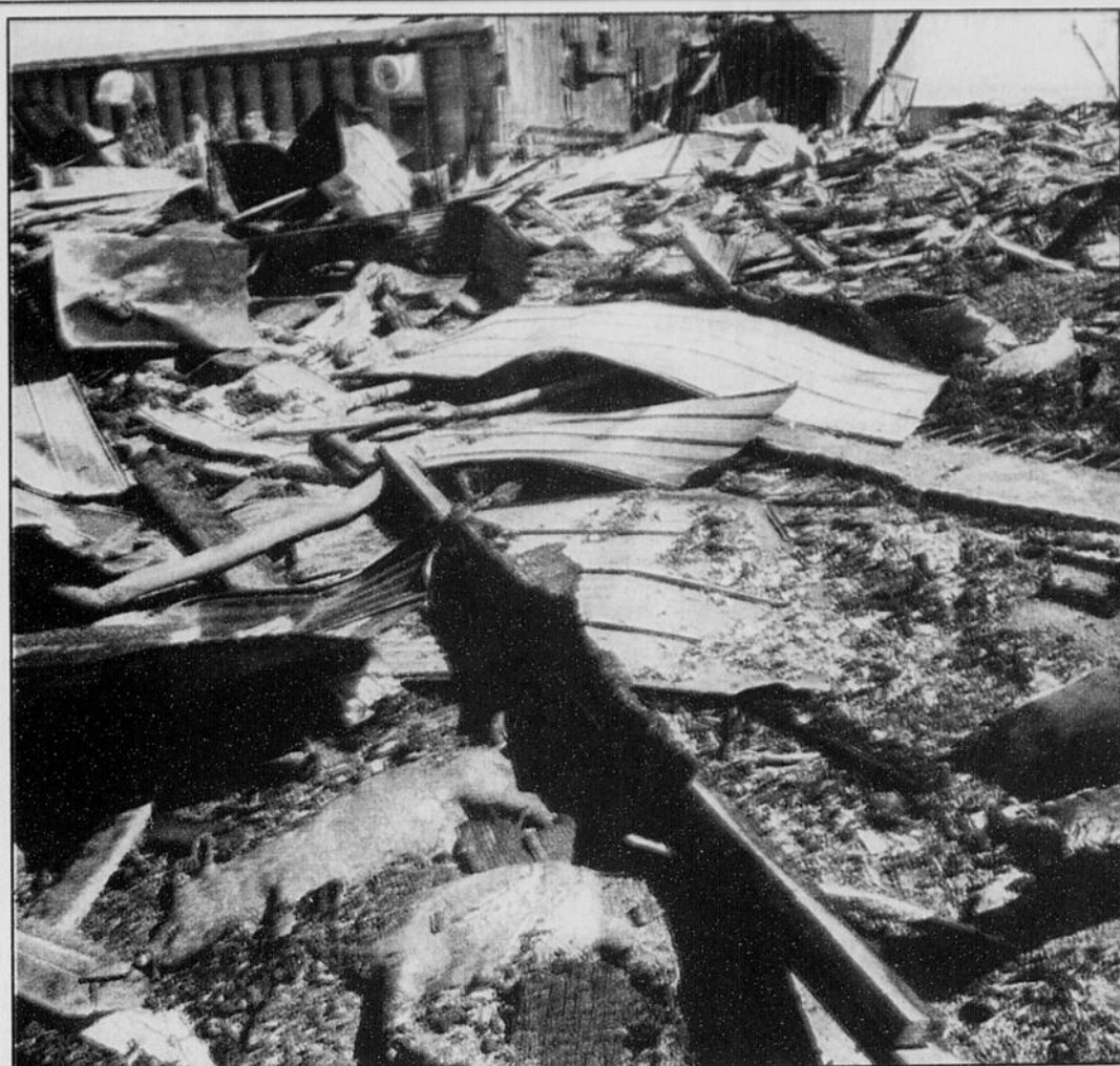
Entre 300 et 400 porcelets ont péri dans l'incendie d'une pouponnière porcine, hier dans le Canton de Newport. Le sinistre aurait été causé par une défaillance électrique. On évalue les dommages à 200 000 $.
