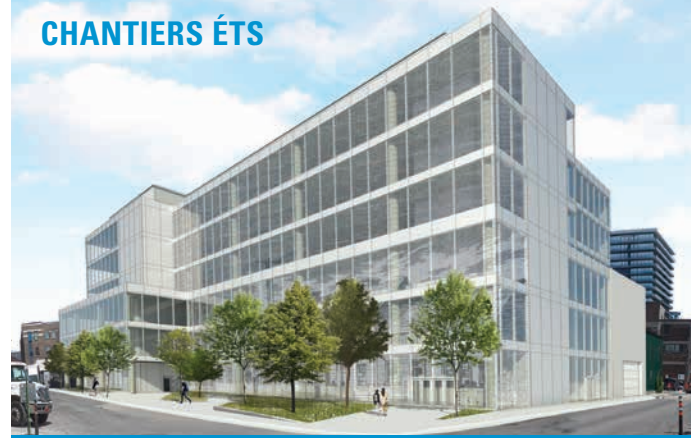
Le chantier du futur pavillon est situé rue William, entre les rues Murray et Young.
