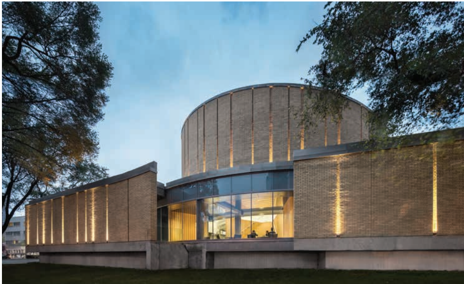
Le Centech a aujourd'hui une partie de ses espaces dans l'ancien Planétarium Dow.
