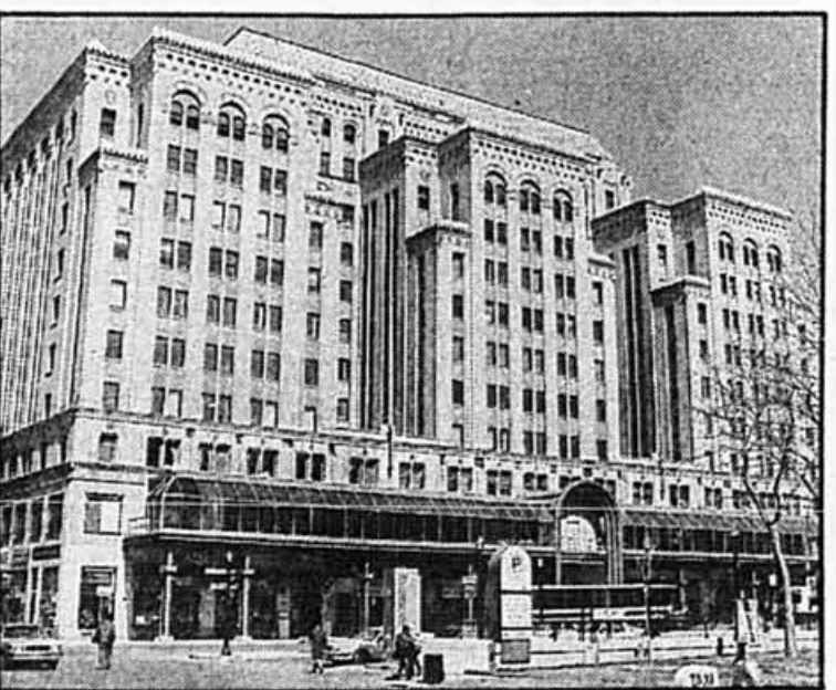
La présente galerie vitrée est une protubérance inacceptable, à l'instar des autres ajouts proposés plus tôt, en 1984, par le même promoteur.
