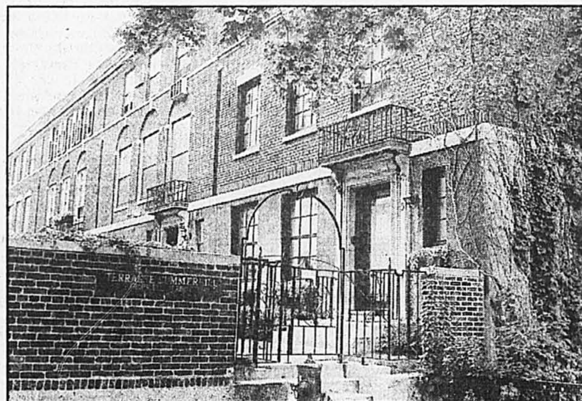
Terrace Summerhill, vue d'ouest en est.
