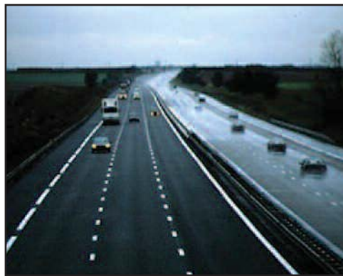
Figure 1 : Revêtement drainant vs revêtement traditionnel par temps de pluie (Photographie : Yves Brosseau)
