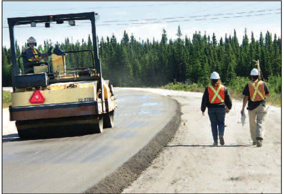
Rehaussement du profil dans une courbe
