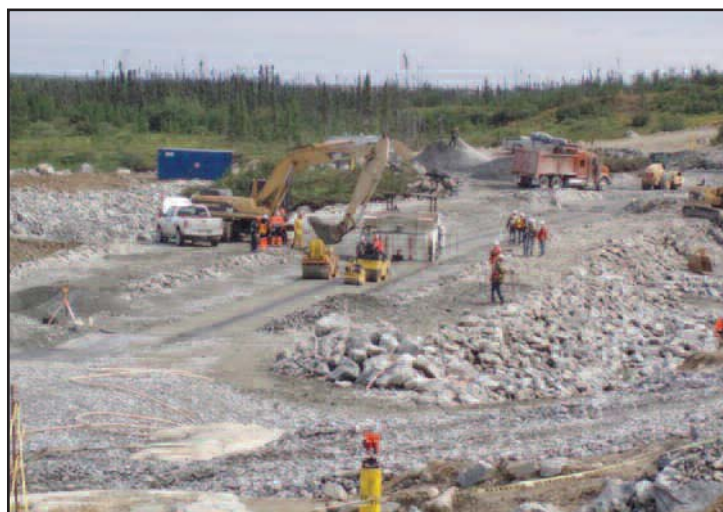
Figure 1 - Vue éloignée de la construction du noyau
