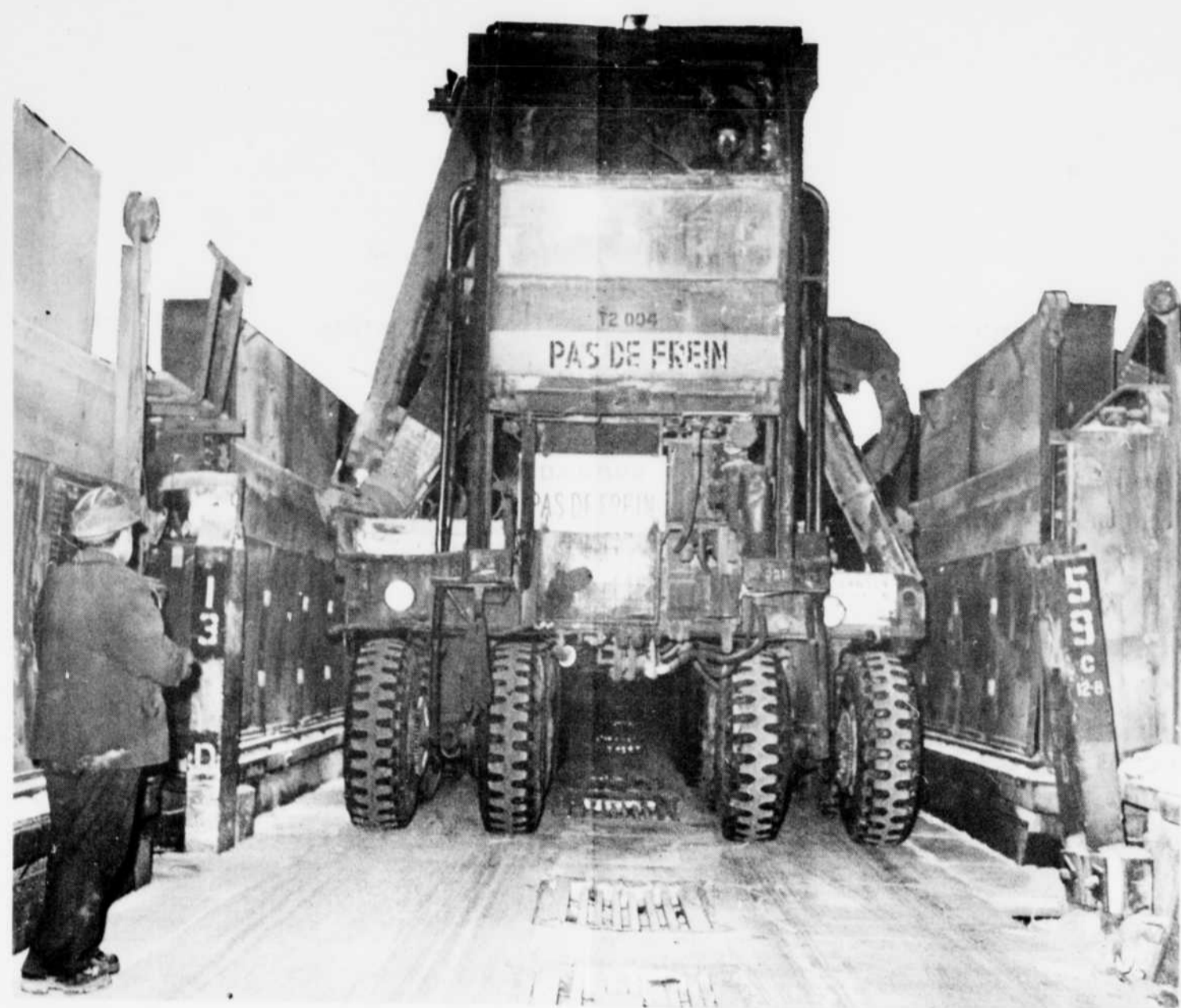
LE MASTODONTE qu'est le transporteur de cuves peut circuler entre deux rangées de cuves, mais l'espace qu'il laisse entre ses roues et les cuves est restreint. Il peut être mortel de passer entre cette machine et les cuves. Quand la machine est au travail, il faut se tenir à l'écart... Quand elle roule, il faut s'en éloigner et quand elle s'arrête, passer dans l'étroit passage entre les roues et les cuves est une imprudence impardonnable.
