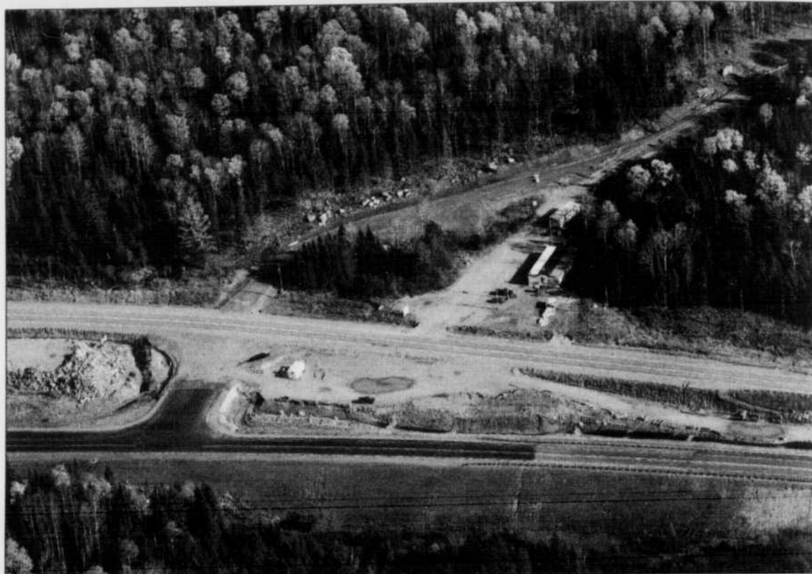
ZEC MARS-MOULIN - L'entrée de la ZEC Mars-Moulin a été totalement modifiée avec les travaux de construction d'une route à quatre voies divisées dans la Réserve faunique des Laurentides. Les amateurs de chasse et pêche profiteront également d'une traverse entre les deux voies. Celle-ci leur permettra d'avoir accès au territoire dans les deux sens de la circulation.
