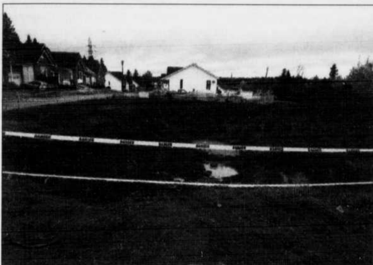
PRIX - Le terrain acquis de Fernand Gilbert ltée par Linda Bouchard et Denis Lévesque, sur la rue des Tuileries, a nécessité une surexcavation importante, ce qui occasionne des coûts supplémentaires d'environ 30 000 $.
