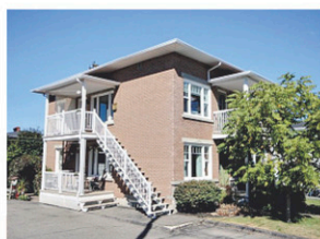
ASBESTOS 173 000$ Beau duplex très bien entretenu et rénové avec goût. Aubaine soyez propriétaire occupant à peu de frais. Garage double, spa, pergola, gazébo, beau paysagement, etc. 819-879-1091 Code: 767580
