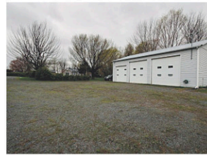
ROXTON POND 440 500$ Bel entrepôt 40x54x16 pieds intérieur. 2 portes de 14x14 et une de 12x12. + de 20 000 pi 2 de terrain. Aussi: maison 13 pièces rénovée en 2011 tous les planchers sont chauffants. 579-488-6505 Code: 765038
