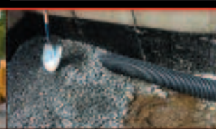
RÉPARATION DE DRAIN FRANÇAIS
