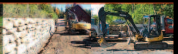
MUR DE SOUTÈNEMENT
