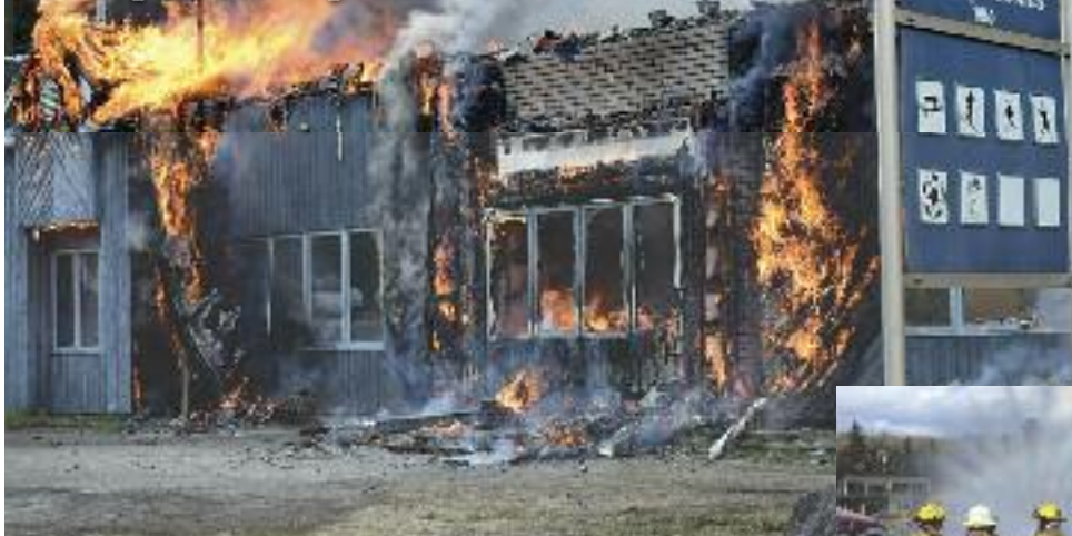
Quinze minutes ont suffi pour que le feu gagne la structure.
