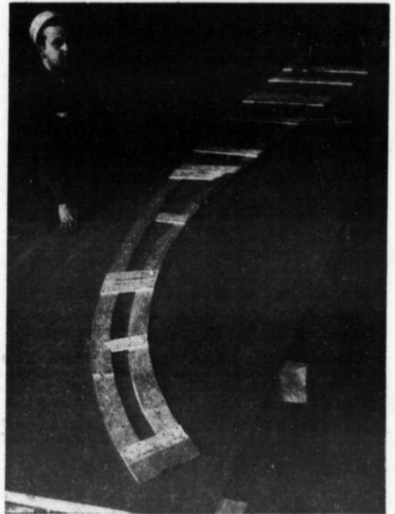
A l'aide d'un plan en bois qui se trouve à l'échelle requise, deux marqueurs, MM. Guy Mongeau et Almanzor Cottelier sont en train de "marquer" une pièce de métal qui servira à la construction d'un navire.
