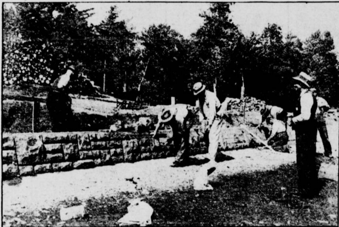
Nous voyons ci-dessus des ouvriers travaillant au Lac des Castors, que le département provincial du Travail est à reconstituer sur le Mont-Royal, lequel lac est disparu depuis plus de trois siècles. On nous affirme que le lac sera terminé, le printemps prochain. Il y aura au centre environ cinq pieds d'eau. On y voit des ouvriers qui sont à poser des pierres de taille sur le contours du lac. Nous avons appris de source absolument certaine que l'on construira tout le tour du lac un trottoir d'une largeur de 10 pieds. De plus nous croyons savoir que l'on mettra, le printemps prochain, dans le lac, diverses sortes de poissons, mais des truites de préférence. Il est même plus que possible que des courses en canot auront lieu sur ce lac artificielle. — Photo la "Patrie".
