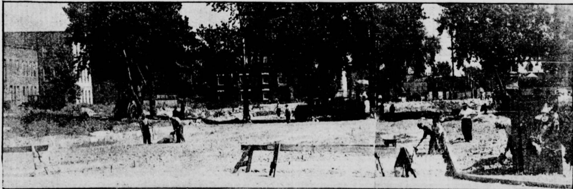
Les ouvriers travaillent actuellement au pavage de la rue Berri, entre Demontigny et Ontario. La ville projette de diviser les terrains qui bordent cette artère afin de tâcher d'encourager la construction, à cet endroit. Il est question de n'y permettre que la construction de maisons de rapport. — (Photo la "Patrie").
