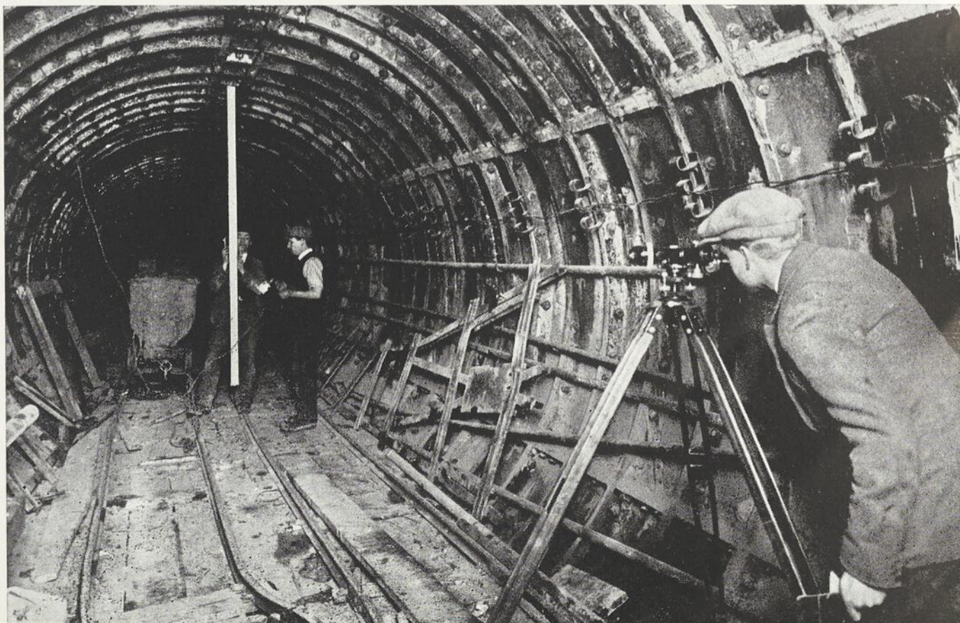
Un arpenteur prend un niveau à l'aide d'un appareil Cooke, en partant d'un repère stable préalablement établi.
