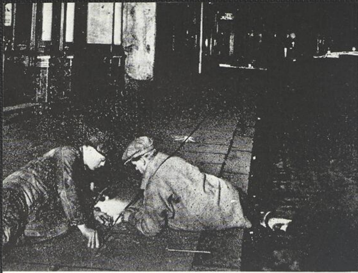
Construction de la section "Morden" de la ligne Northern, à Londres, en 1926. A gauche, alors que la population dort, des techniciens tracent sur les trottoirs l'endroit exact où passera, en-dessous, la ligne médiane de chacun des deux tunnels parallèles dans lesquels le métro circulera.
