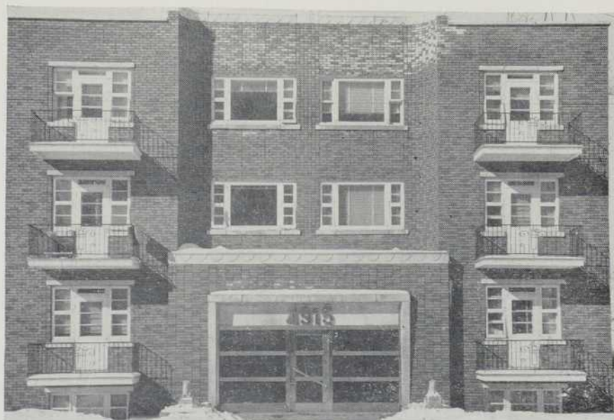
APPARTEMENT sur le Chemin Sainte-Catherine, à Montréal. Architecte, Roméo-J. Desjardins.
