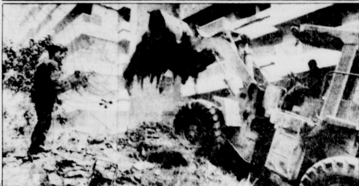
Un soldat libanais surveille le démantèlement par un bélier mécanique d'une partie de la barricade entre les secteurs chrétien et musulman de Beyrouth.
