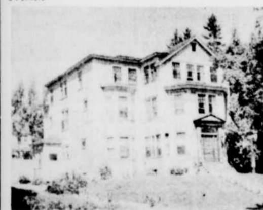
Maison de 6 logements chauffés et meublés, située au 423, rue Québec. Rapporté $6,700.00 par année. Prix $40,000.00
