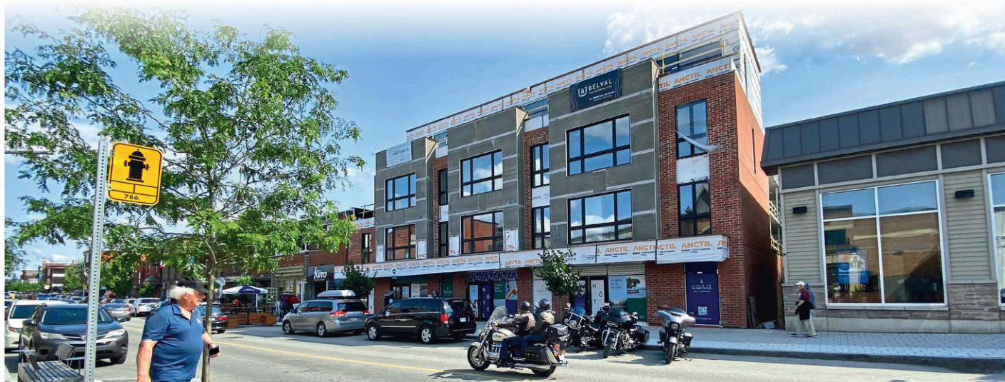
L'Atelier du pain occupera l'un des locaux commerciaux situés au rez-de-chaussée du nouveau bâtiment, construit par le promoteur William Belval. (Photo Le Reflet du Lac - Pierre-Olivier Girard)
