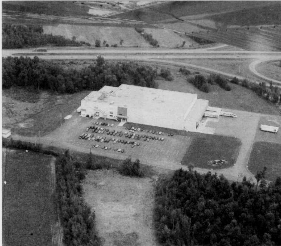
Une toute nouvelle usine de découpe des plus modernes a été construite en 2001 à Ange-Gardien.
