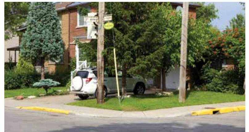
Le marquage en jaune garantit la visibilité des piétons, cyclistes et automobiles aux intersections.
