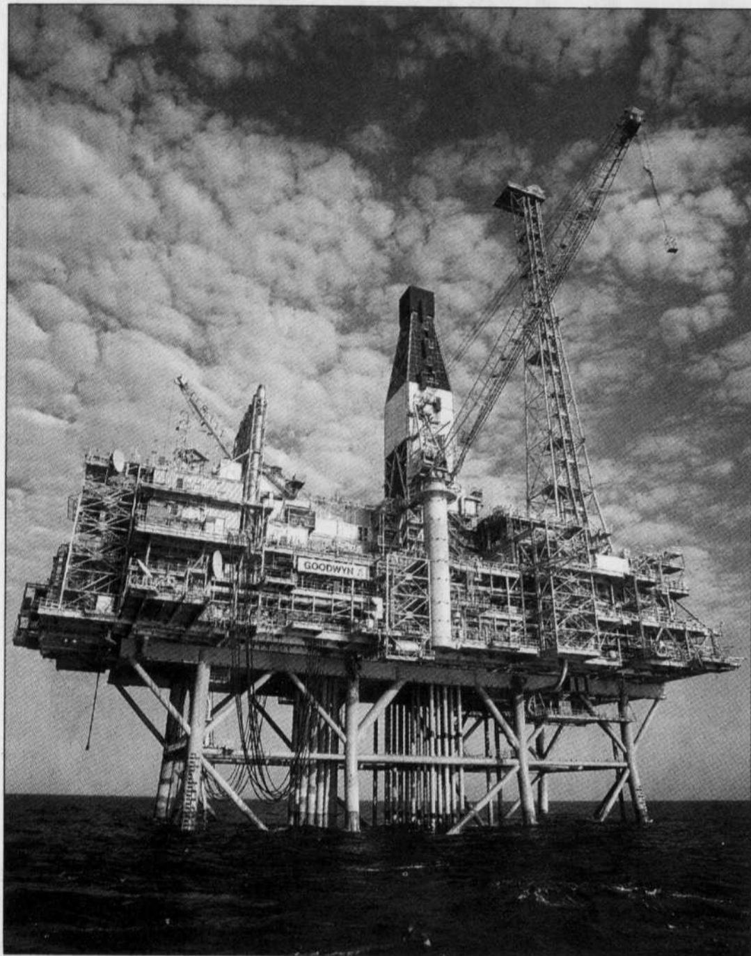
La plateforme de forage Goodwyn A au nord de l'Australie.
