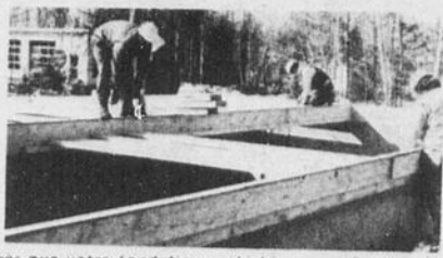
Après que votre fondation a été bien montée, nos érecteurs s'apprentent à faire le charpentage du plancher. Aucun soliveau ne touche à la fondation ce qui vous assure d'avoir des planchers toujours solides. Nos soliveaux sont des pièces de 2" x 10" au lieu de pièces de 2" x 8" de même que le contreplaqué à 3/4" de pouces d'épaisseur au lieu de 5/8" de pouces. Vous assurez de la qualité "STRUCTOME".
