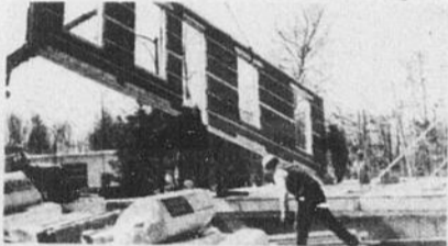
Nos murs sont préassemblés en usine et l'isolation est posée dans des conditions idéales de température évitant ainsi les intempéries qu'entraîne la construction ordinaire. On pose une planche isolante sur les 2 cotés des murs avec les lottages prêts à recevoir les revêtements extérieurs et intérieurs.
