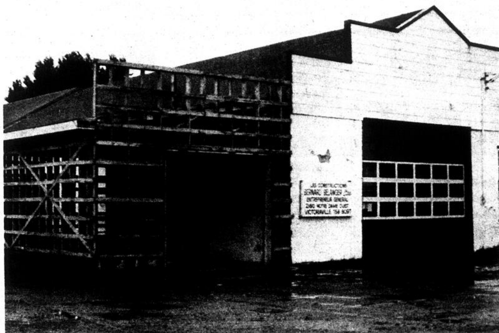
Les travaux vont bon train afin de doter la municipalité de la paroisse de Plessisville d'un entrepôt de calcium et de pierres. Les travaux de la rue Cormier devraient bientôt être terminés. (Photo LP)
