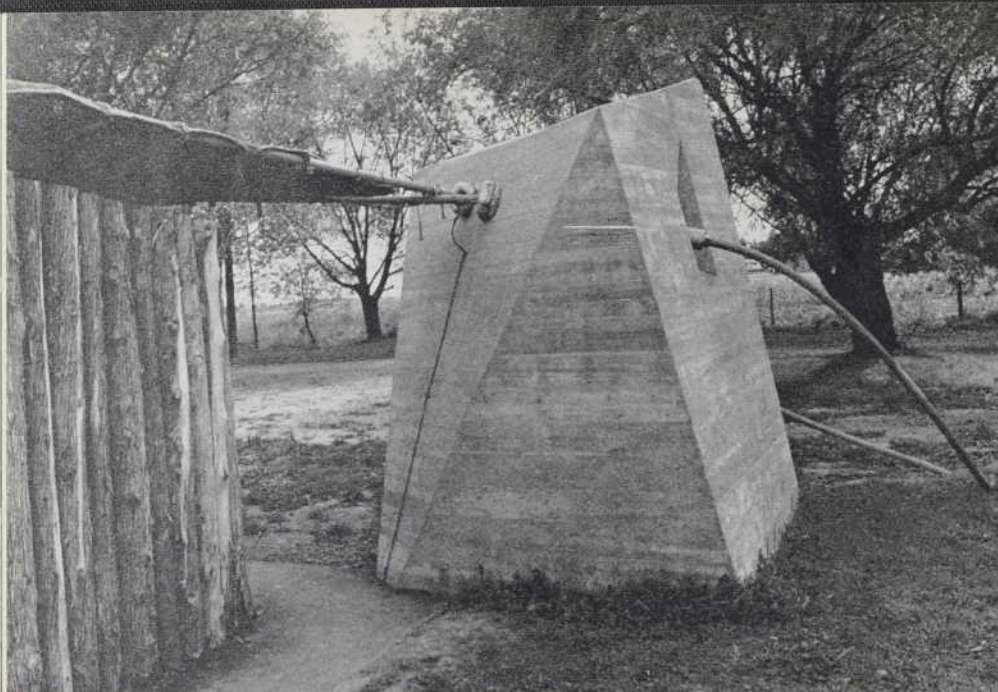
1 — détail d'un des petits pylones où sont ancrés les câbles de rive.
