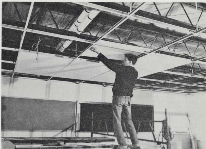
— Montage d'un plafond suspendu "Firegrid". Les panneaux s'encastrent simplement dans la grille; des joints fusibles permettent à la grille de se dilater sans se tordre.
