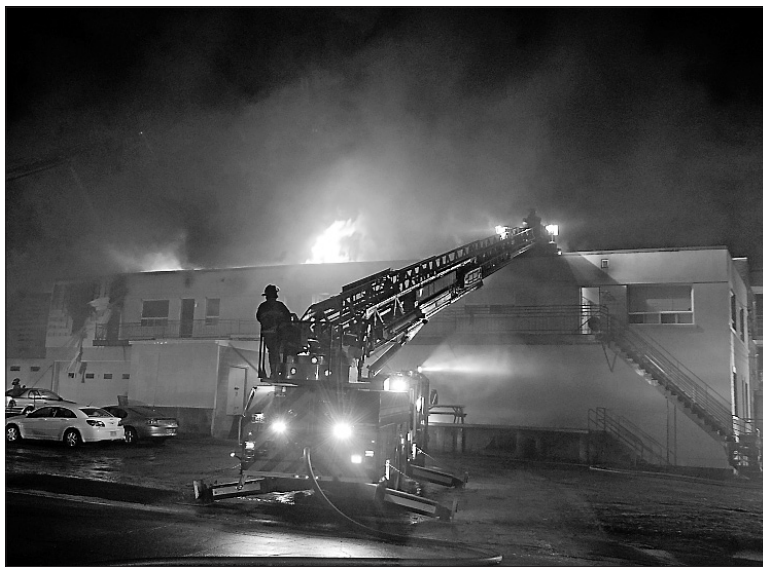
Un incendie a lourdement endommagé un immeuble de la rue Coutu à Shawinigan. — PHOTO: SYLVAIN MAYER
