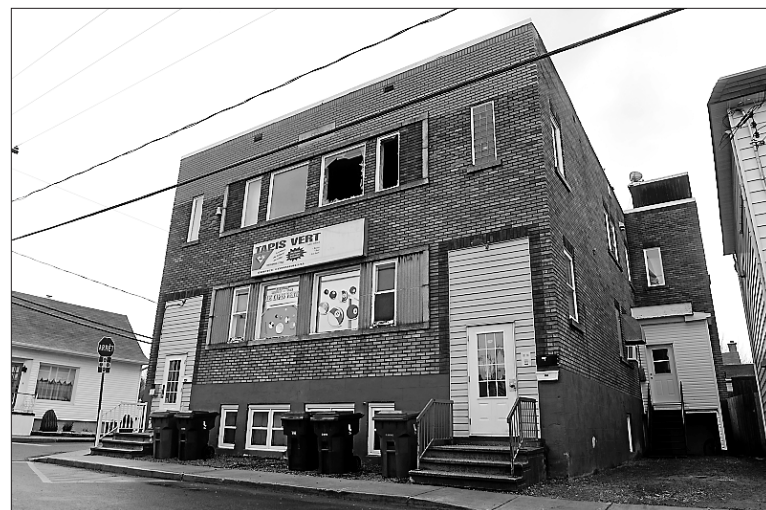
Le salon de billard Le tapis vert ainsi que trois logements ont subi des dégâts lors d'un incendie mercredi soir à Louiseville. — PHOTO: FRANÇOIS GERVAIS
