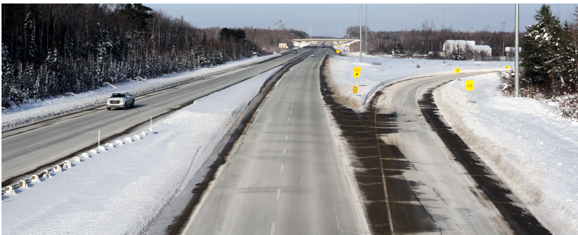
Figure 19 – Coloration blanche de la chaussée causée par l'excès de sel de voirie à la suite de l'évaporation de l'eau
