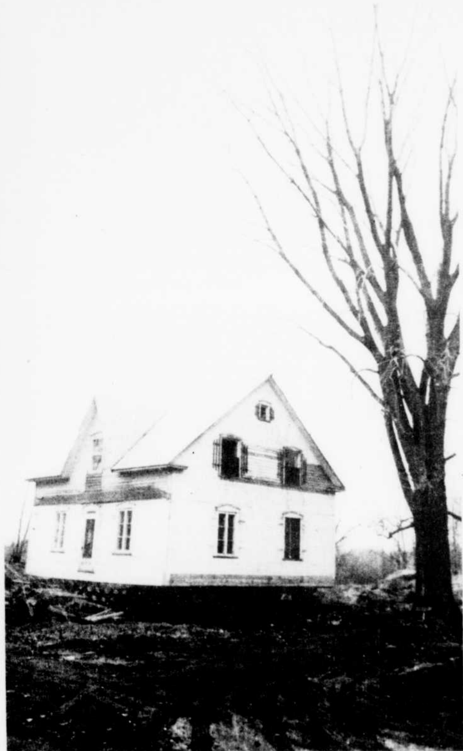
Après avoir parcouru 15 milles sur les routes, depuis St-Zéphirin jusqu'au village d'antan, la maison Jutras attend maintenant son solage et les travaux de finition extérieure et intérieure.
