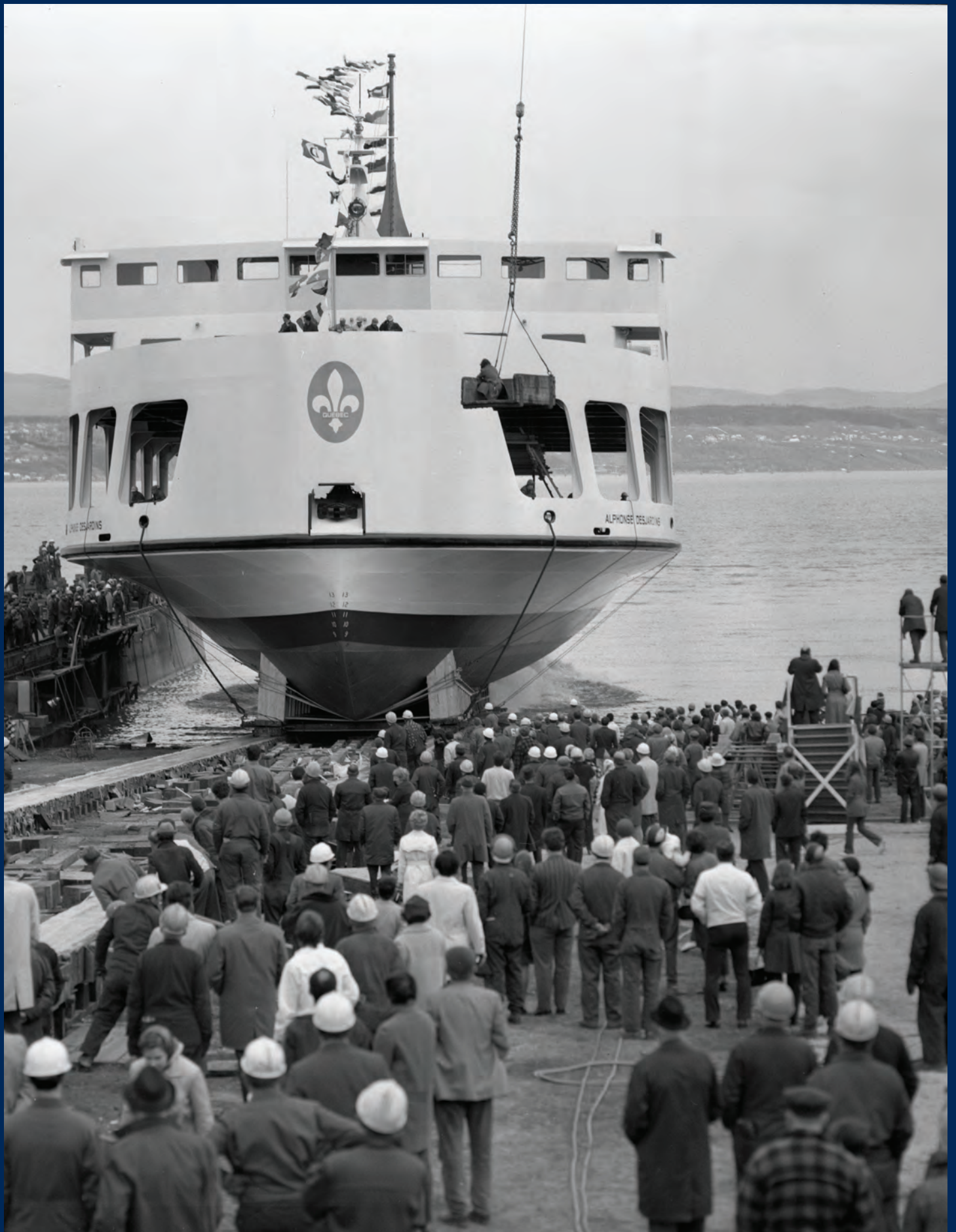
Archives historiques de la Ville de Lévis - chantier du NM Alphonse-Desjardins
