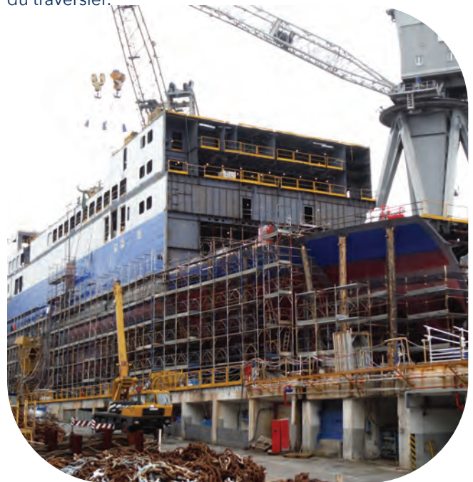
Archives STQ - construction du NM F.-A.-Gauthier 2014
