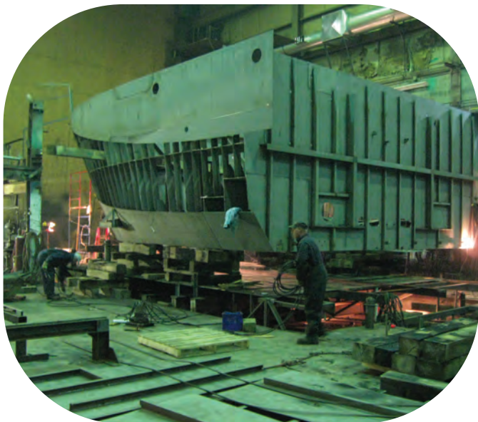
Archives STQ - Construction du NM Ivan-Quinn
