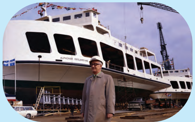
Archives historiques de la Ville de Lévis - Construction du NM Alphonse-Desjardins
