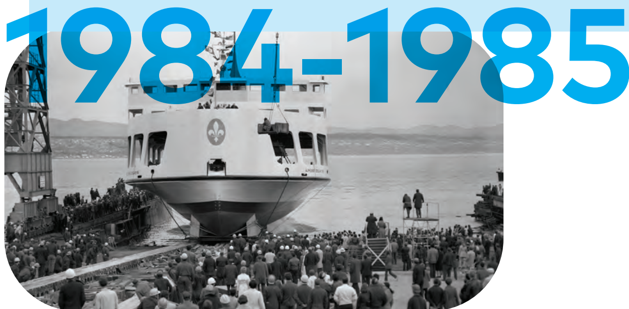
Archives de la Ville de Lévis - Chantier Davie
