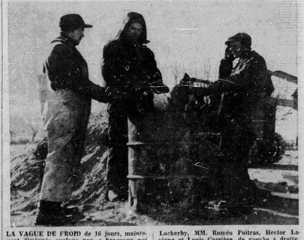
LA VAGUE DE FROID de 16 jours, maintenant diminuée quelque peu, a beaucoup nué au progrès des projets de construction, à Sudbury. Nous voyons ici trois proposés à l'installation d'égouts dans la section de Lockerby, MM. Roméo Poitras, Hector Lavigne et Louis Carrière, de gauche à droite, devant se réchauffer à cause d'un froid sibérien de 20 sous zéro, avant de continuer leur travail. (Photo NIS)
