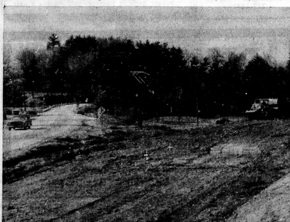
MOINS DE VICTIMES SUR LA ROUTE 11 — La "côte d'un mille" et la "courbe de la mort" ne tiennent maintenant que par un fil. La photo ci-dessus nous montre le tracé de la nouvelle route où les travaux de nivelage arrivent presque à terme. A gauche, et en haut nous voyons la présente route 11, étroite et tortueuse. On prévoit que les travaux de cette nouvelle partie de la route vers la Gatineau seront terminés pour la fin novembre. (Photo Champlain Marclil)
