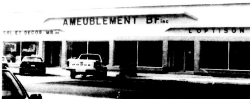
Juillet 1985 Reconstruction de Ameublement B.F. - Double surprise.
