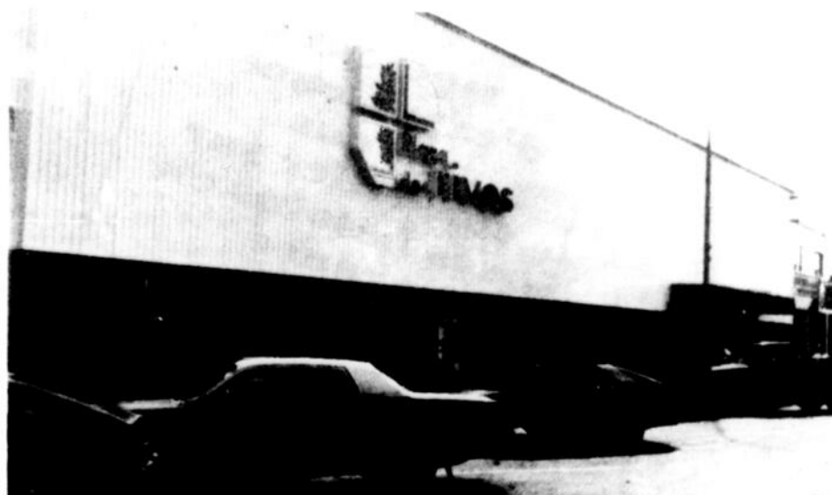
Une réalisation d'envergure nécessitant audace et volonté d'investir dans le milieu pour donner de la vie au centre ville.
