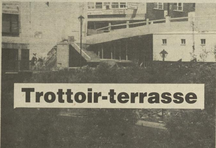
Le côté sud de la passerelle du centre-ville s'agrémentera maintenant d'un trottoir-terrasse suspendu, qui permettra, une fois complété, aux piétons de se rendre du secteur ouest de la rue Principale au centre d'achat, à la bibliothèque, tout en admirant les berges nouvellement aménagées de la Yamaska. Ce trottoir-terrasse se complète par un escalier, qui mène du niveau de la rue Principale à celui du rez de chaussée du Domaine du Parc, et de là à la promenade piétonnière, qui longe la rivière. L'aménagement de ce trottoir-terrasse permettra au centre-ville de Cowansville de "s'ouvrir" davantage encore aux piétons, aux promeneurs.
