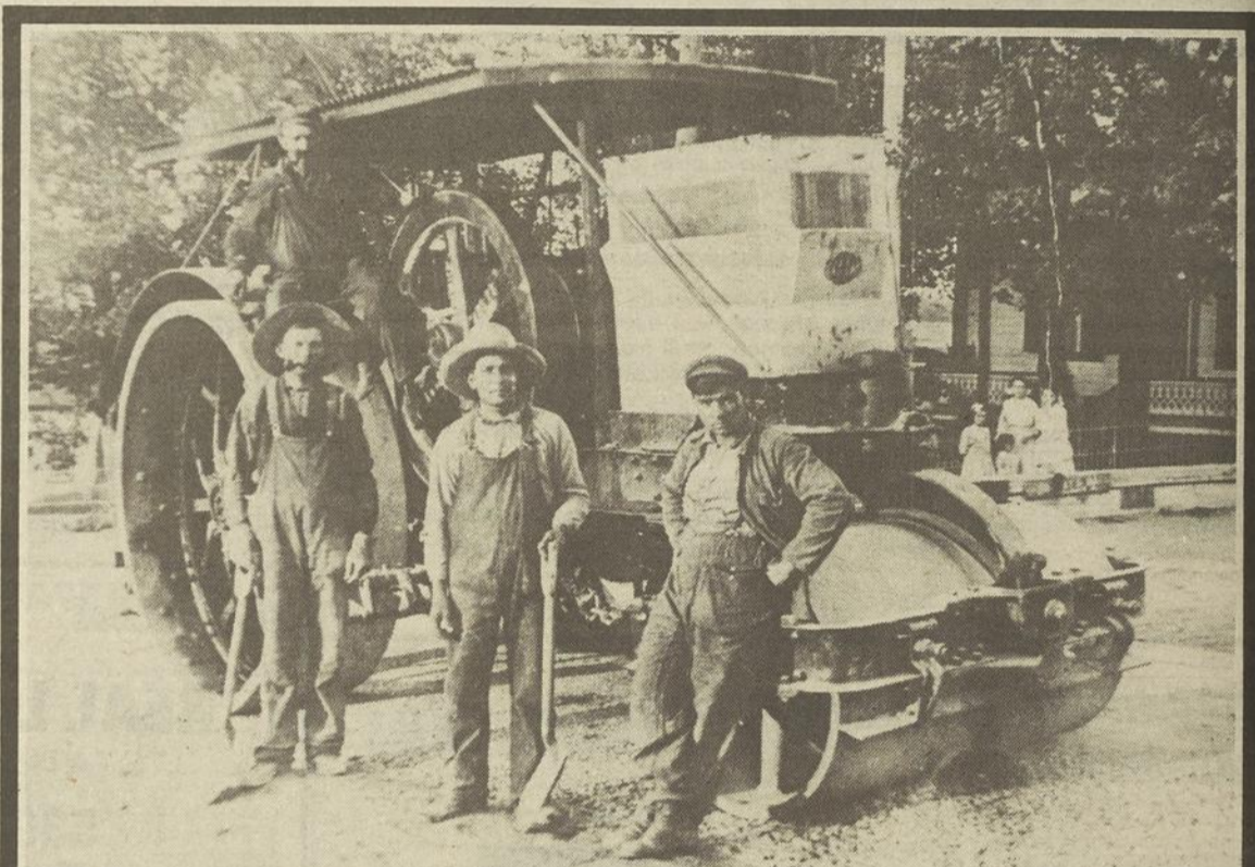
À Valcourt, vers 1920, l'un des premiers rouleaux-compresseurs utilisés pour paver les routes.
