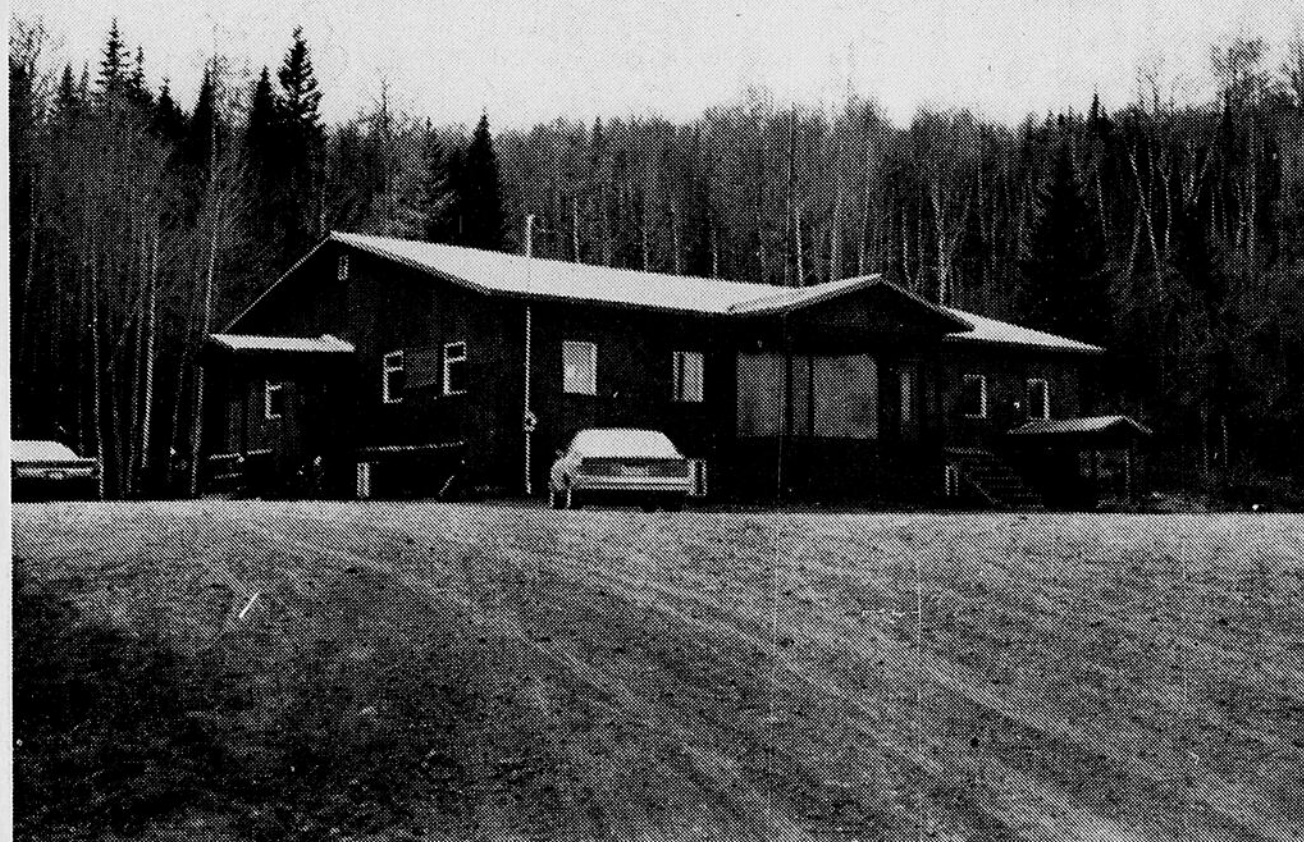
EDIFICE CENTRAL — C'est le grand chalet du Centre de plein air de Lac Bouchette.
