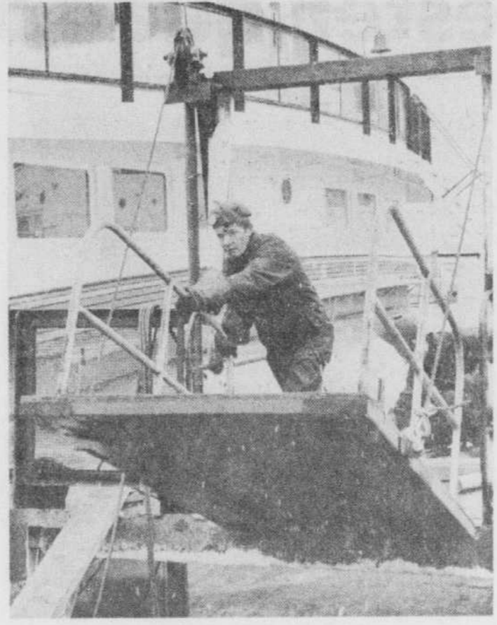
PONTON — Avant d'entrer en service, le "Radisson" doit d'abord être doté de pontons mobiles pour permettre aux passagers de débarquer et d'embarquer sans encombre.
