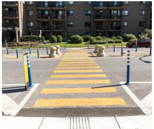
Après les travaux
