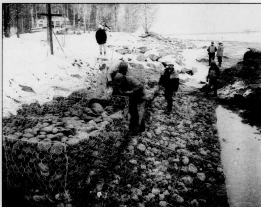
Une protection de gabions installée dans le secteur de Saint-Prime.
