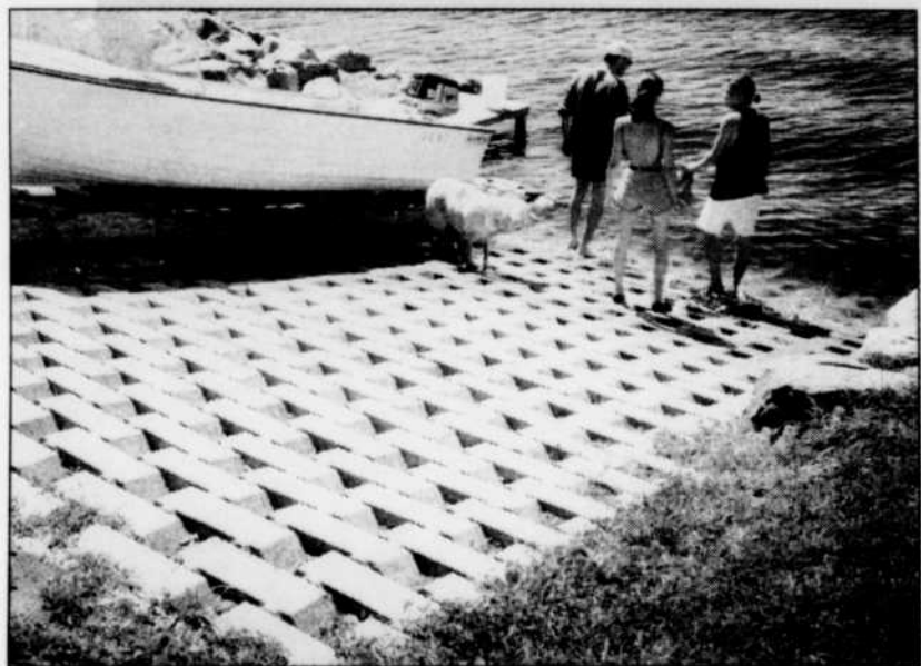
Une descente de chaloupe en blocs de béton.
