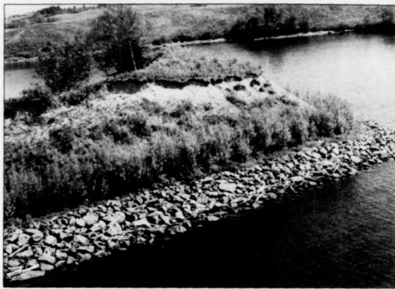
Un perré ayant fait l'objet d'une revégétalisation le long de la Grande-Décharge à Delisle.
