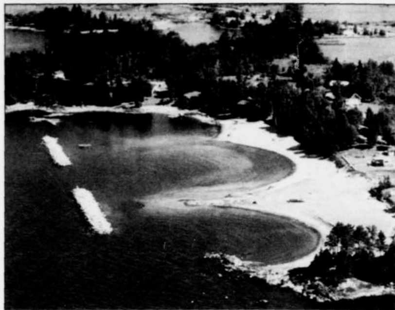
Brise-lames construits en 1988 à Saint-Gédéon.
