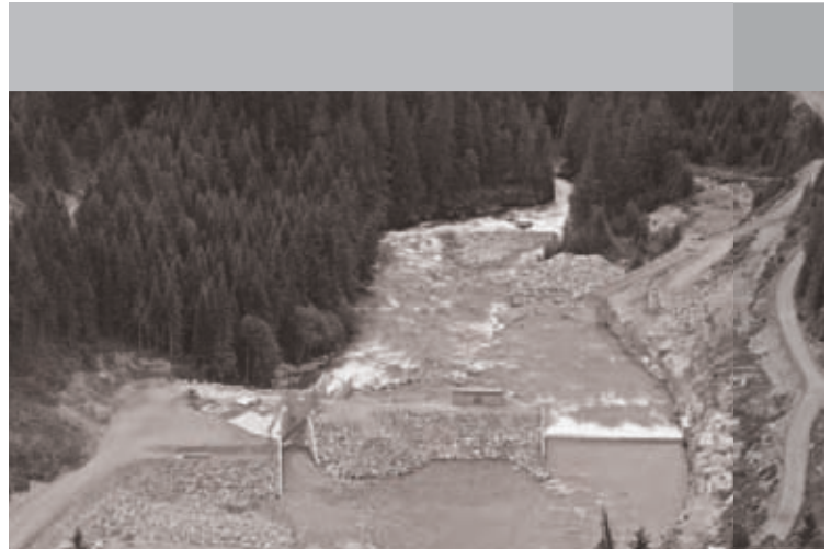
Léonard Énergie Projet hydroélectrique Ashlu Creek (49.9 MW) à Squamish, Colombie-Britannique
