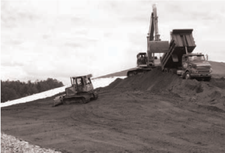
Léonard Environnement Restauration du site 1, complexe minier Eustis, en Estrie
