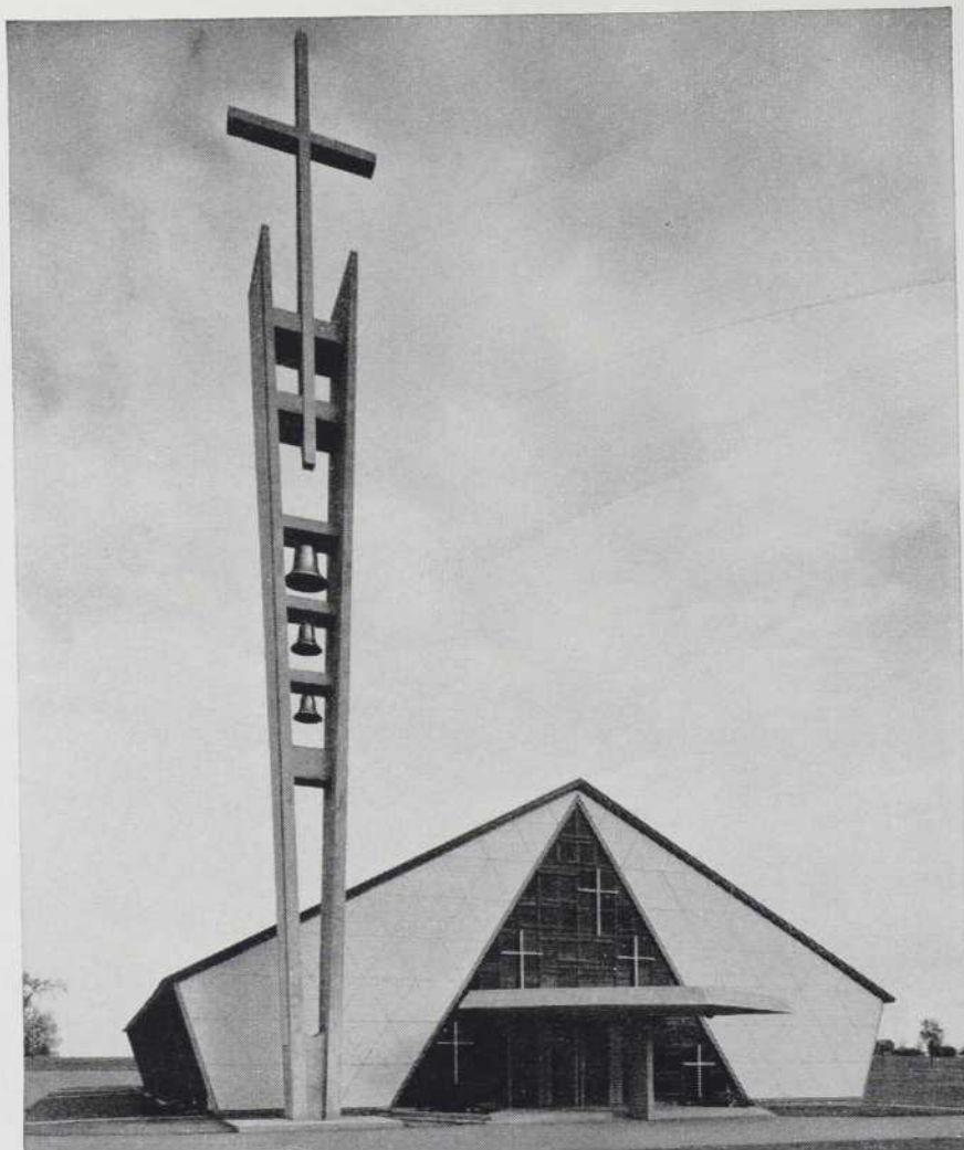
Eglise Notre-Dame-Reine-du-Monde, Richmond Hill, Ontario. Architectes: Gilleland and Janis, Ingénieurs-conseils en charpente: McNamara Engineering Limited, Entrepreneurs généraux: Perwin Construction Company Limited. Fournisseurs de béton: Dual Mixed Concrete and Materials Company. Le béton POZZOLITH a été utilisé dans la construction de l'église et du clocher. Le jointoyage du clocher a été fait au moyen de mortier liquide EMBECO sans retrait, de Master Builders.
