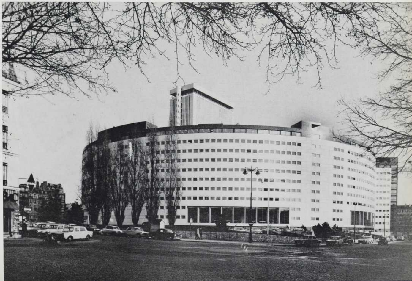
façade sur la rue Boulainvilliers
