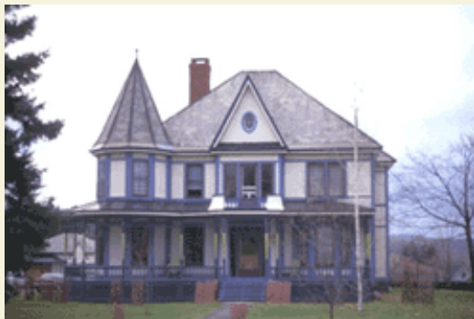
Tuiles en ardoise sur la toiture d'une maison dans la région de Danville
