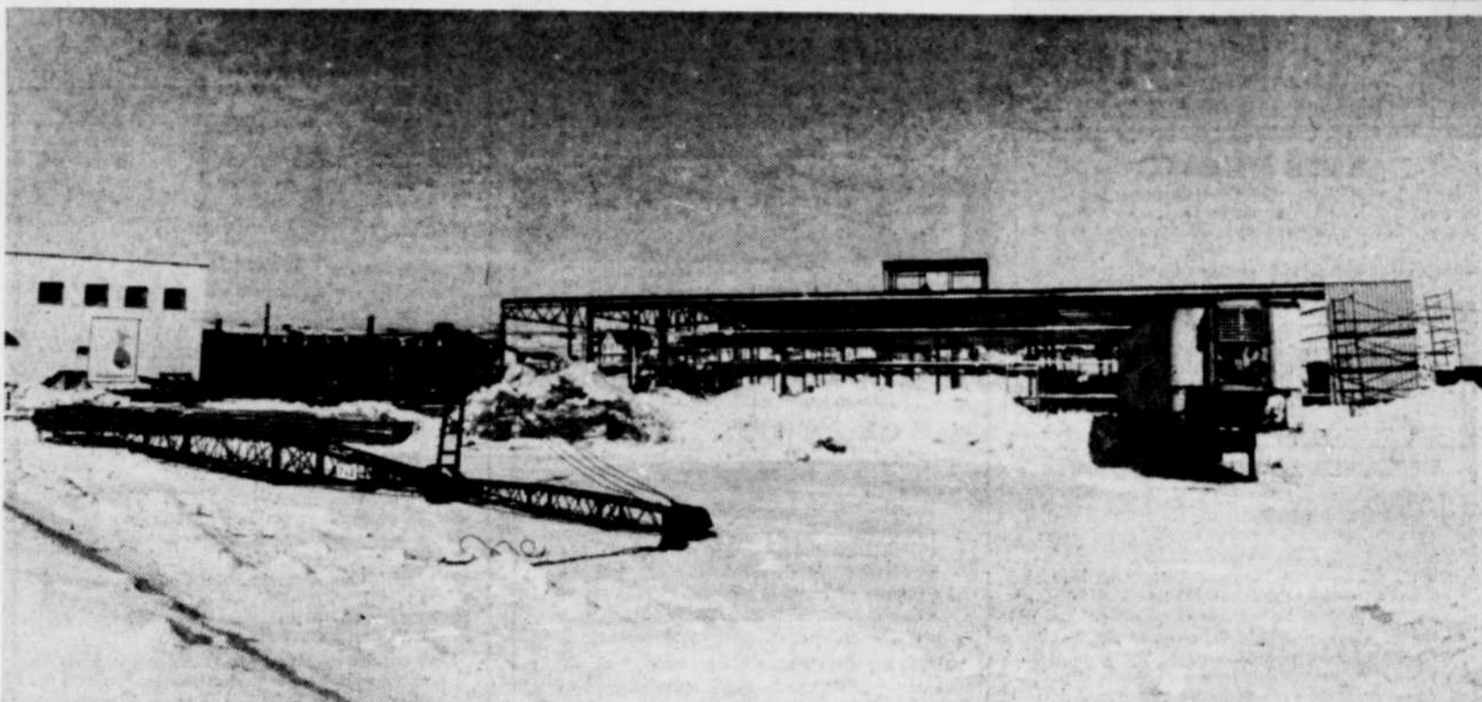
Même si le projet n'a été annoncé officiellement que jeudi, l'agrandissement de l'usine de traitement de poissons de fond de Cap-aux-Meules est en cours depuis un bon moment comme en témoigne cette photo prise jeudi. Les travaux d'agrandissement et de modernisation de l'équipement nécessitent des investissements de plus de $7 millions de la part du gouvernement du Québec.
