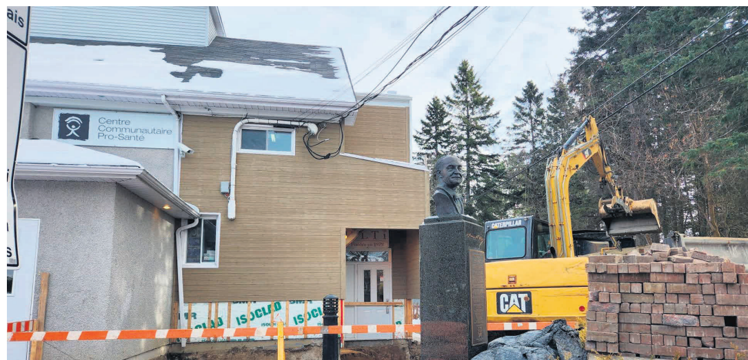
Les travaux d'excavation ont débuté la semaine dernière au Centre communautaire Pro-Santé.
