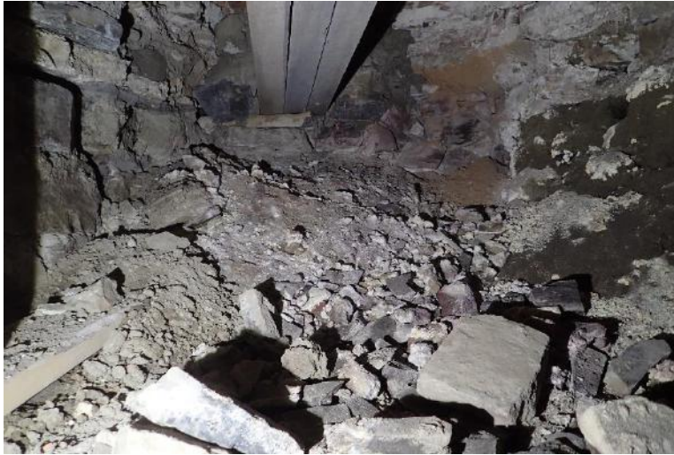
Figure 95. Vue générale du mur ouest – CeEt-600-23A1600 – à l'intérieur du massif, vue vers l'ouest (Artefactuel, photo 248).
