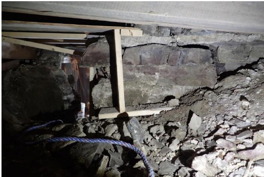
Figure 94. Parement nord du vestige CeEt-600-23A1200, à l'intérieur du massif, vue vers le sud (Artefactuel, photo 176).
