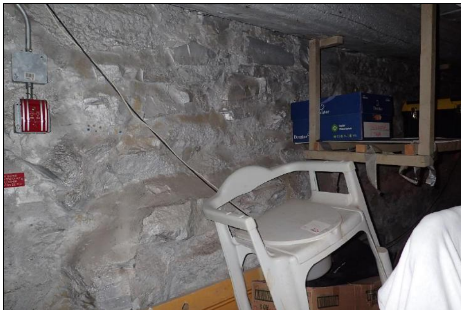
Figure 30. Portion centrale de CeEt-600-23A400, mode 1, vue vers le sud-ouest. Notez le bombement (Artefactuel, photo 257).
