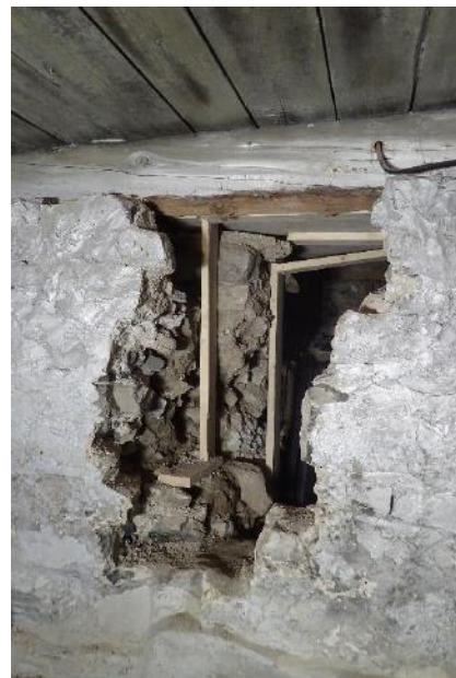
Figure 53. Démantèlement partiel dans le mur sud du massif – CeEt-600-23A100 – pour l'implantation du sondage 23A, vue vers l'ouest-nord-ouest (Artefactuel, photo 288).
