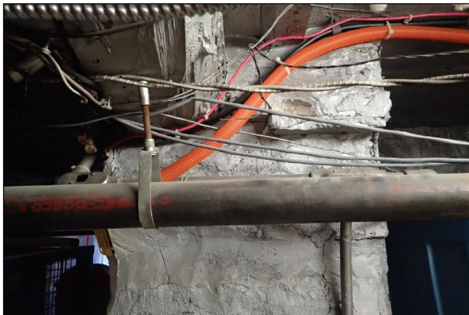
Figure 35. Portion supérieure du parement est de CeEt-600-23A1300, vue vers l'ouest (Artefactuel, photo 158).
