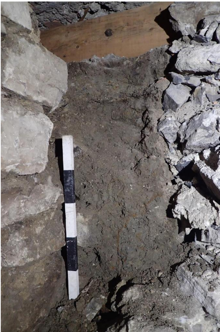
Figure 57. Paroi est localisée entre les murs CeEt-600-23A100 et CeEt-600-23A1200, vue vers l'est (Artefactuel, photo 70).
