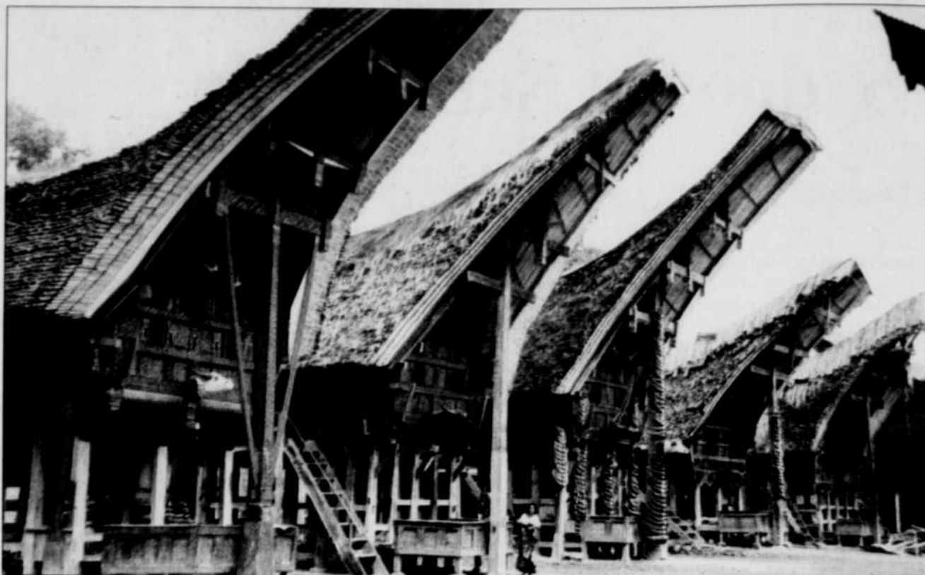
Façades de maisons torajas
