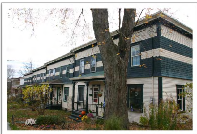
Maisons en rangée, rue Fulton
