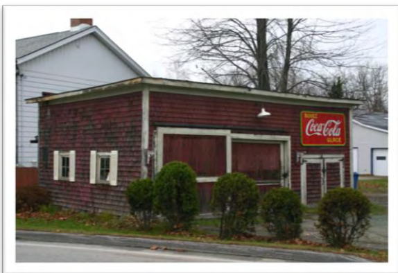
Hangar situé à l'arrière de l'Édifice sis au 6625, rue Émery-Fontaine
