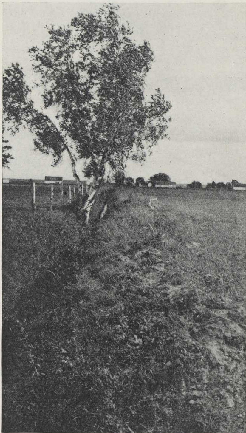
Un fossé de ligne dont les bords sont trop élevés.
