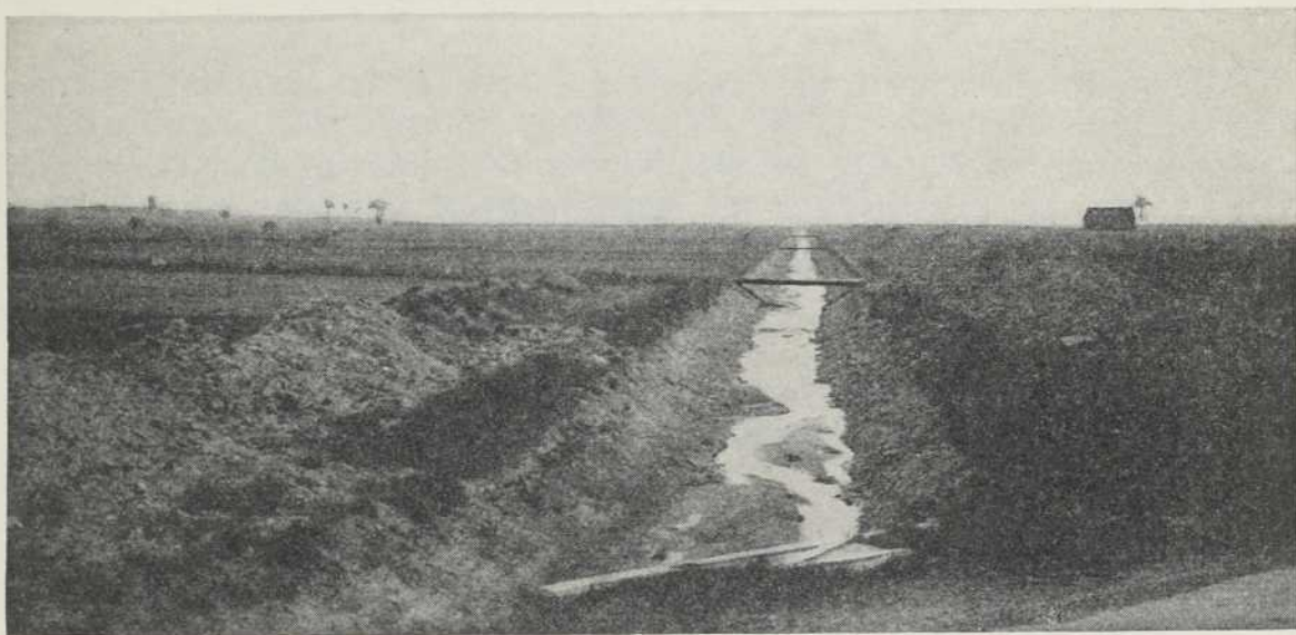
Après le passage de la pelle mécanique.
